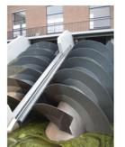
Vis d'Archimède utilisée pour pomper l'eau des Polders hollandais
